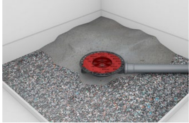
Schritt 2: Nun wird die Fläche mit Estrich verfüllt.
